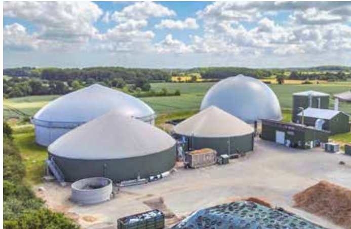
Betreiber von Biogasanlagen stehen durch die 44. BImSchV vor neuen Herausforderungen. Das Regenerative Speicherkraftwerk der Naturenergie Sterup GmbH ist dank neuester Technik und flexibler Fahrweise für die Zukunft gewappnet. Fotos: Agrarservice Lass
