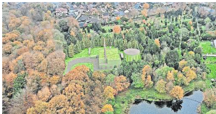
So sieht der Entwurf für das Heizhaus Schriebershof im Bürgerpark aus, die Arbeiten haben im Herbst 2024 begonnen.
